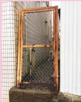
▲ フェンスの向こうには、吉原とその外をつなぐ跳ね橋に通じると思われる横道が見える。
